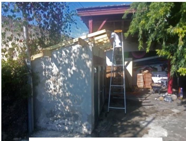
Réfection toiture des toilettes
