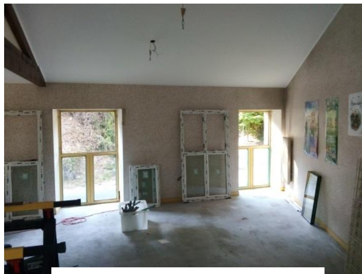
Rénovation thermique de la bibliothèque
